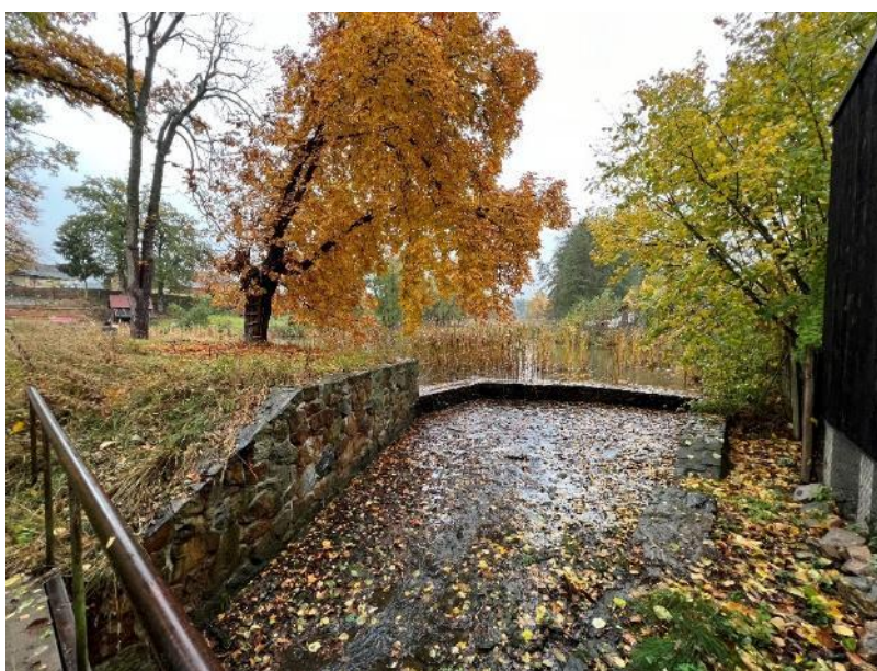
Obrázek 16 -Vlastní foto bezpečnostního přelivu
