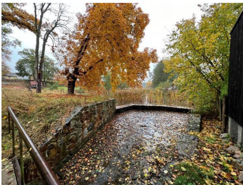
Obrázek 16 -Vlastní foto bezpečnostního přelivu
