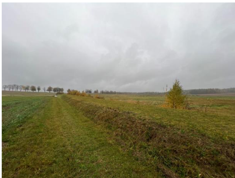
Obrázek 9 – Vlastní foto hráze suchého poldru
