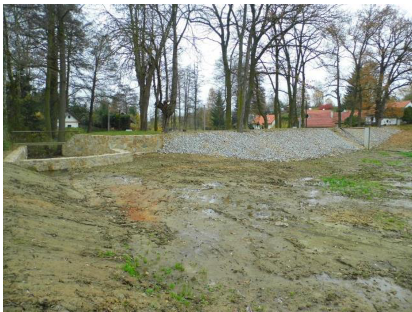
Obrázek 18 - Fotodokumentace hráze – MěÚ Tábor
