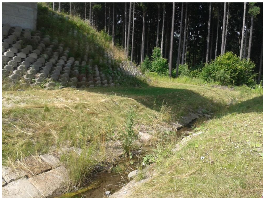
Příloha 4: Migrační podchod na koridoru Celnice před úpravou pískové plochy v srpnu 2016, pohled ze západu
