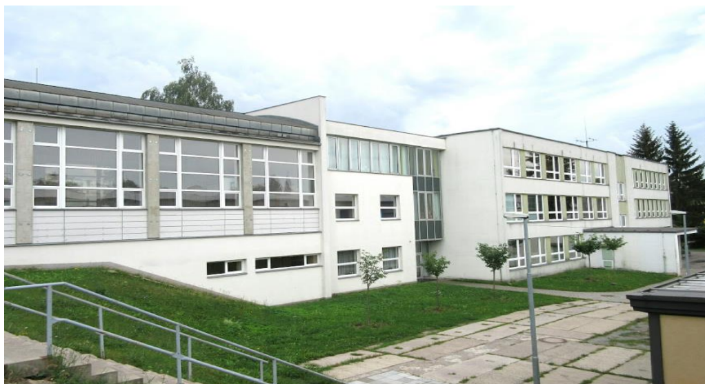
Obr. 18 - Budova Základní školy Masarykova v Rychnově nad Kněžnou (Ht, 2016)
