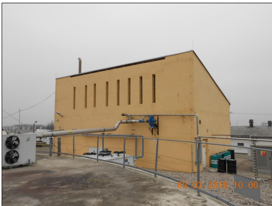
Obr. 5: Budova kogenerace (Frank Kristová, 2018)
