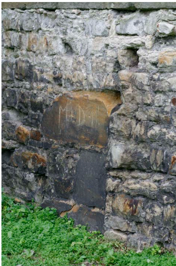
22. Založení dalšího pilíře presbytáře na severní straně lodi kostela (foto autor).
