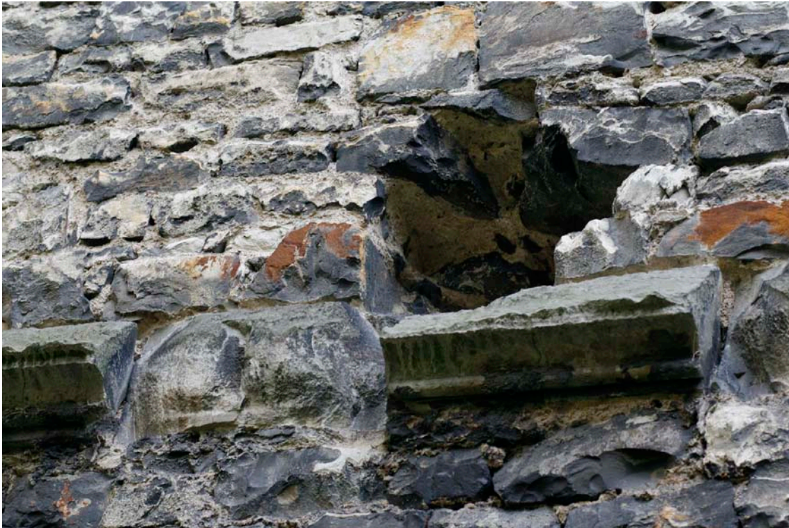
5. Detail druhotně vysekaného otvoru se zbytky římsy na severní stěně presbytáře (foto autor).
