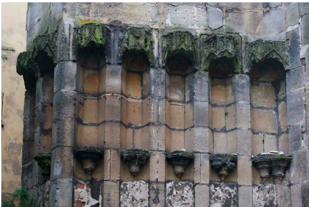
34. Galerie nik na západní straně portálu (foto autor).
