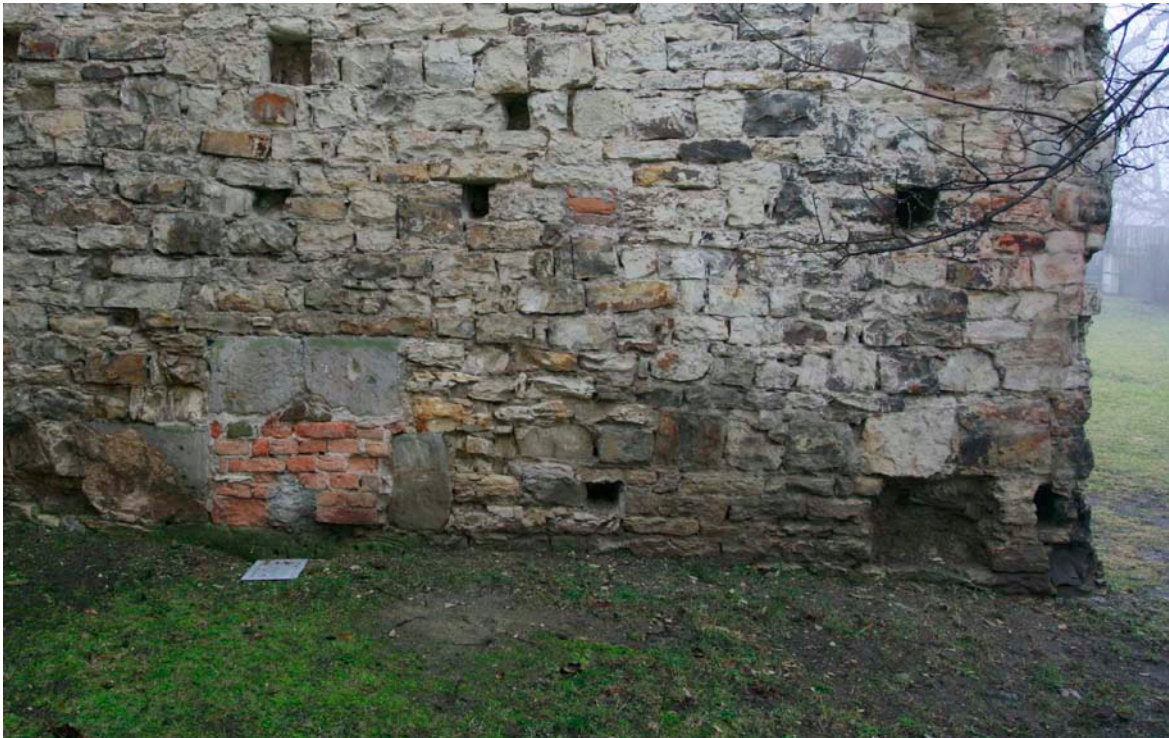
26. Zazděné okénko v západní stěně lodi z lodi kostela (foto autor).
