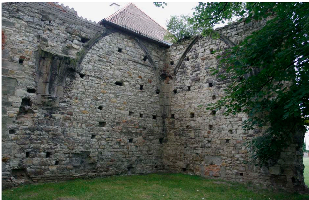
23. Nedostavěná loď kostela, jihozápadní část (foto autor).
