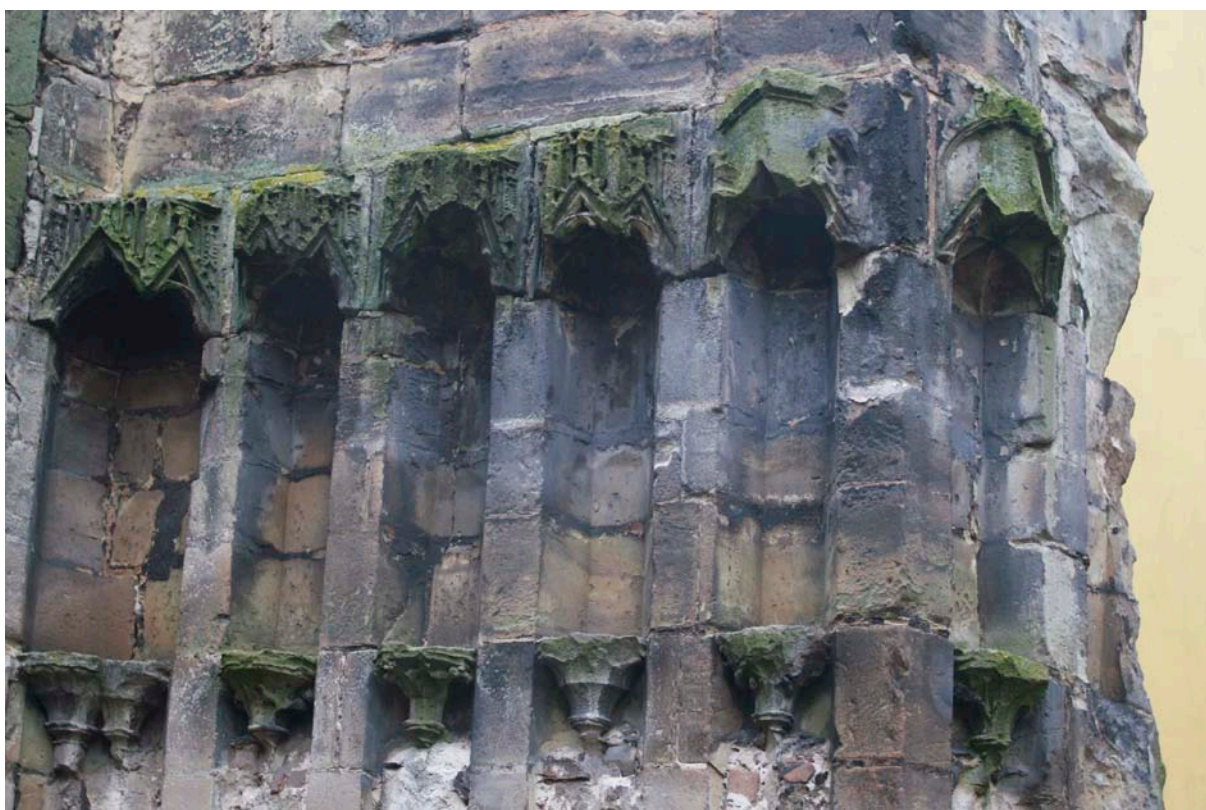
35. Galerie nik na východní straně portálu (foto autor).
