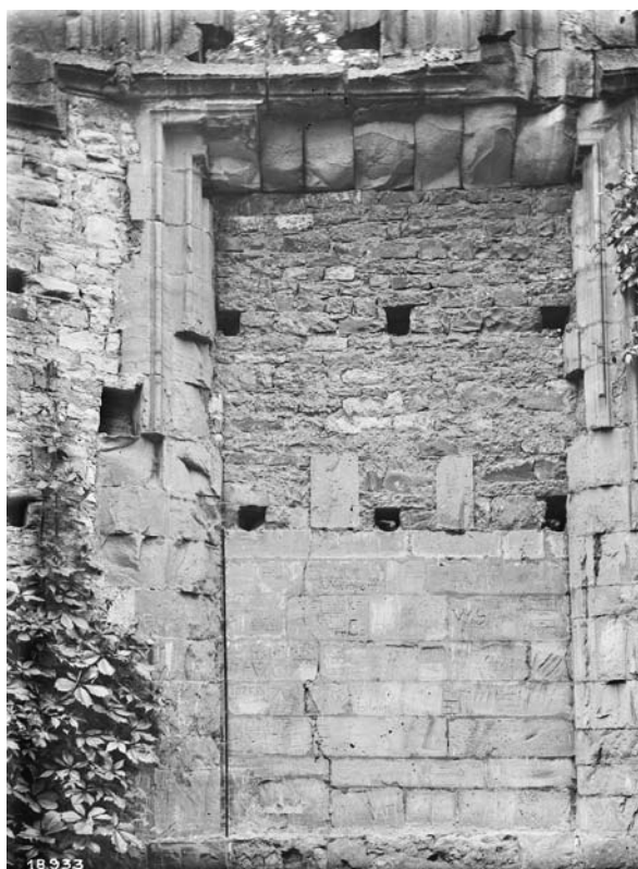
16. Sedile v 50. letech se zachovalejší římsou pod okny (foto archiv NPÚ).
