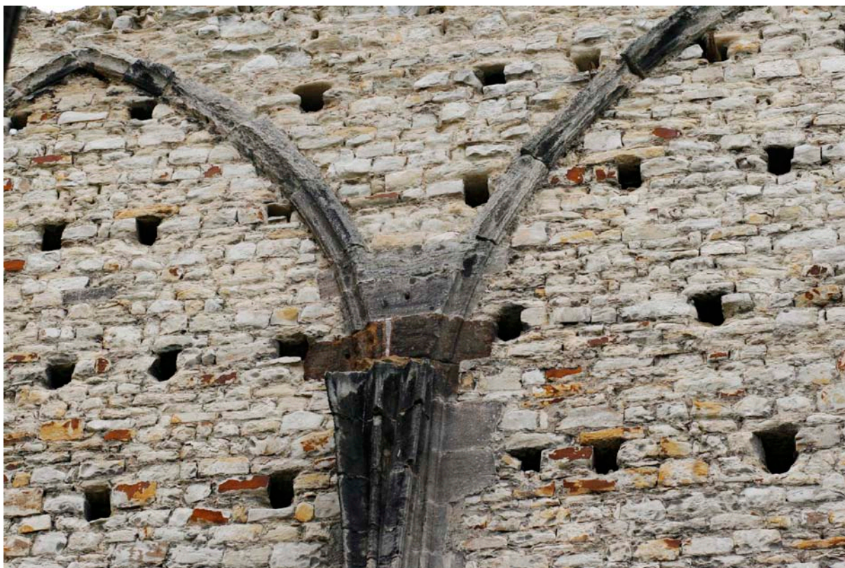
8. Přípora s oblouky klenebních žebér na severní stěně presbytáře (foto autor).
