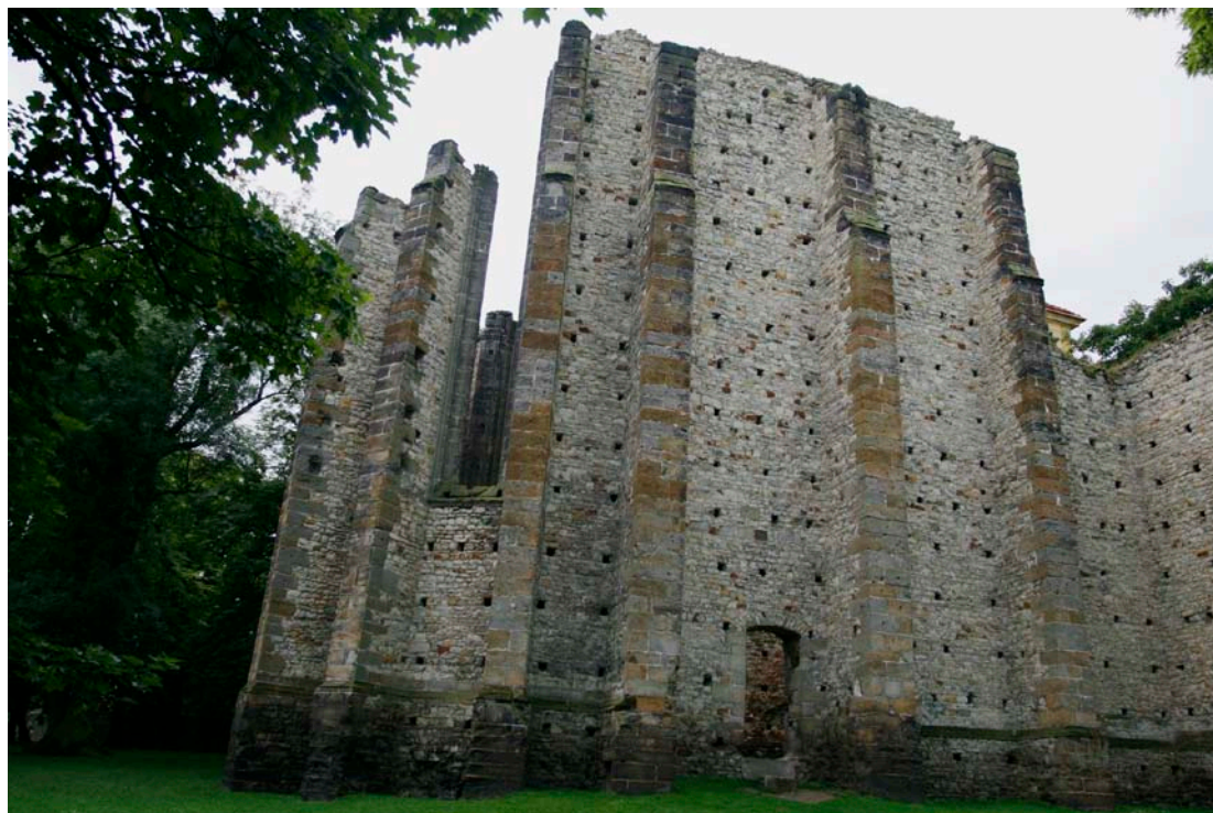
54. Severní stěna presbytáře kostela v Panenském Týnci s kapsami po lešení.
