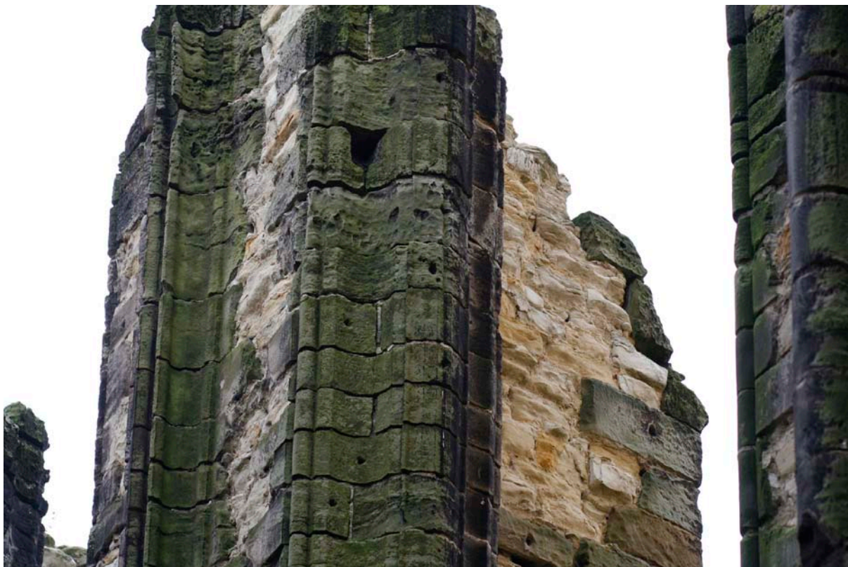
56. Detail napojení opěrného pilíře. Rozdílné použití pískovce a opuky (foto autor).
