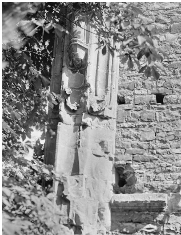
21. Fotografie výzdoby na severní straně vítězného oblouku z 50. let s ještě zachovanou konzolou (foto archiv NPÚ).
