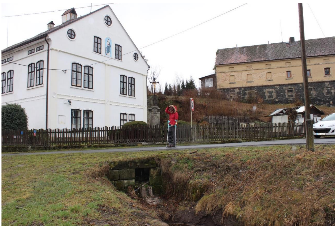
Mlýn Lindava 87, rekonstruovaný objekt, odpad (foto: Marie Legnerová 16. 3. 2019)
