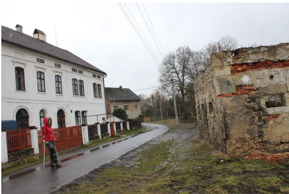
Torzo zdiva přilehlé budovy (foto: Marie Legnerová 16. 3. 2019)
