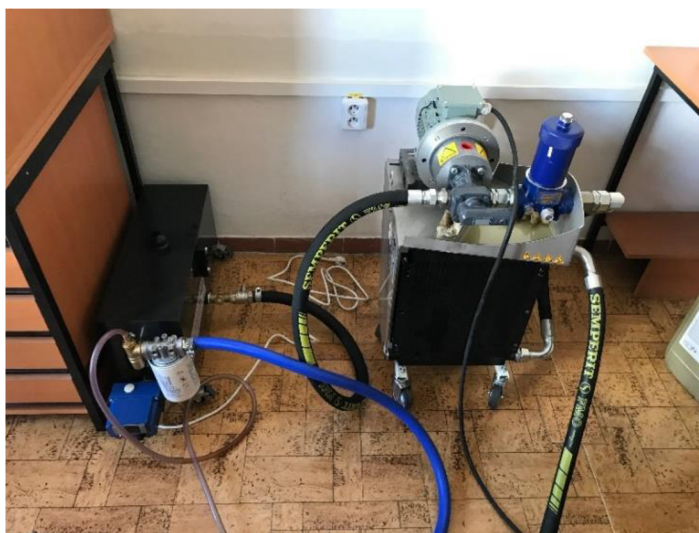
Obr. 41 Olejové hospodářství. Vlevo olejová vana a filtr, vpravo olejové čerpadlo s výměníkem tepla.
