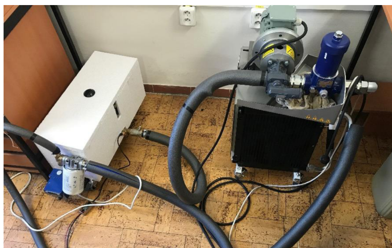
Obr. 56 Ukázka izolace olejové vany a potrubí.
