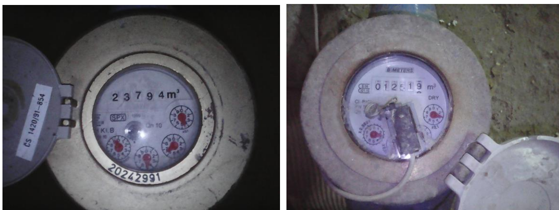
Obrázek 30 Pravidelné odečty spotřeby celkové (SV+TV – v levo) a teplé (TV – v pravo) vody
