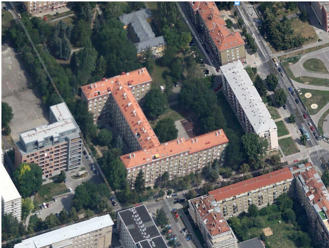
Obrázek 22 Řešený bytový dům, Brno, lokalita Ponava
