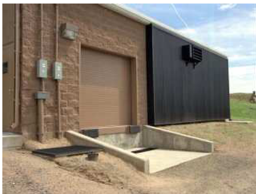
Vzduchový kolektor na fasádě
