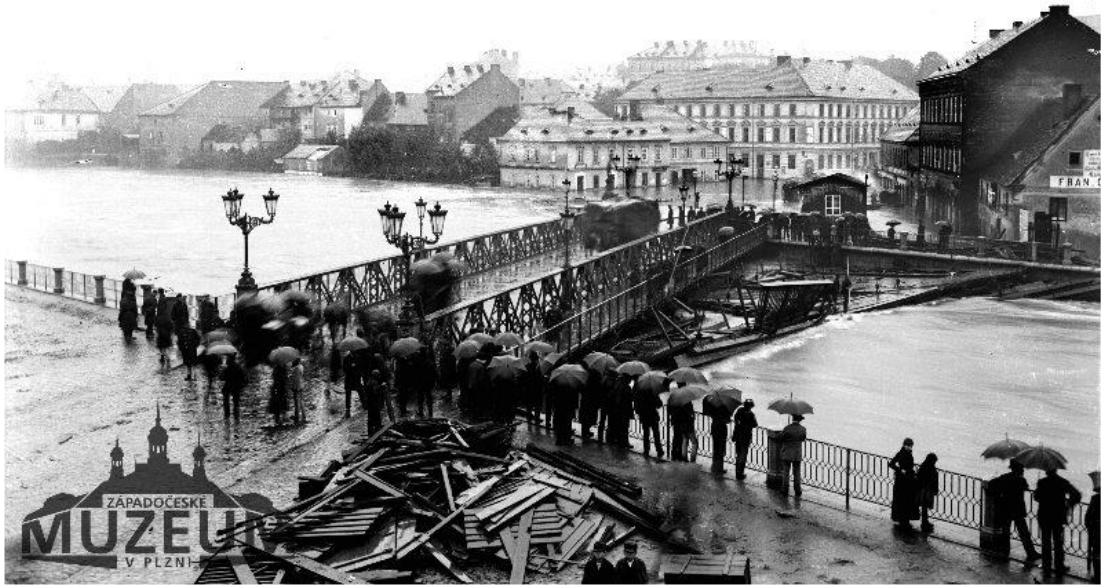
Obr. 16: Nový železný most přes Radbuzu (dnešní most u Jána) při povodni roku 1890 (Sbírka Západočeského muzea v Plzni In: Cais, Vodřich, 2011)
