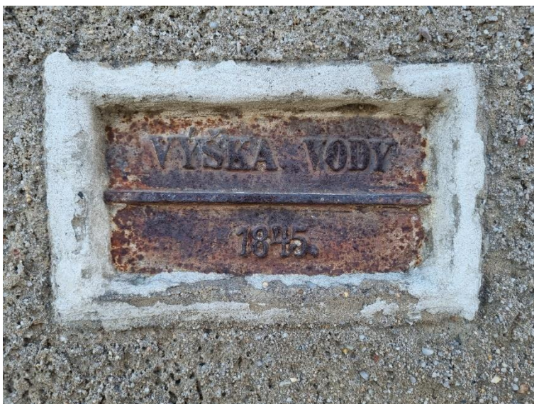
Obr. 11: Povodňová značka z roku 1845 na Roudné, ul. Luční 205/36 (foto: autor)
