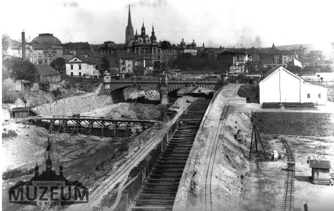
Obr. 6: Stavba regulace nábřeží Radbuzy, vzadu dnešní Wilsonův most (Sbírka Západočeského muzea v Plzni In: Cais, Vodřich, 2011)
