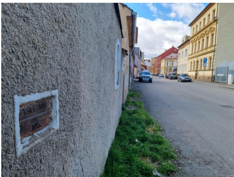
Obr. 12: Povodňová značka z roku 1845 a okolí na Roudné, ul. Luční 205/36 – umístěna na cihlové zdi cca 80 cm nad zemí (foto: autor)
