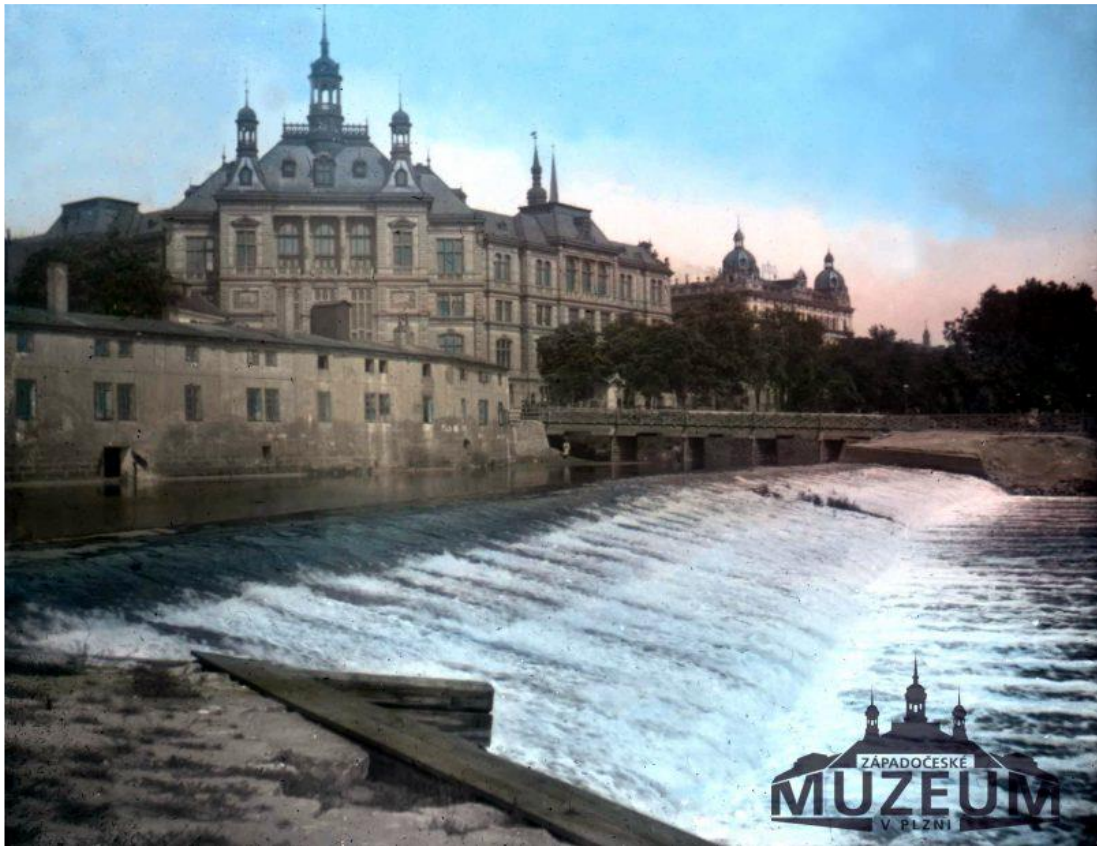
Obr. 3: Královský jez na Radbuzě s Královským mostem a budovou muzea v pozadí (Sbírka Západočeského muzea v Plzni In: Cais, Vodřich, 2011)
