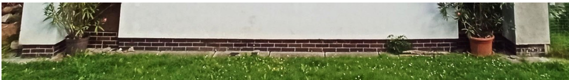
Obr. č. 13: kabřincová podezdívka [autor]
