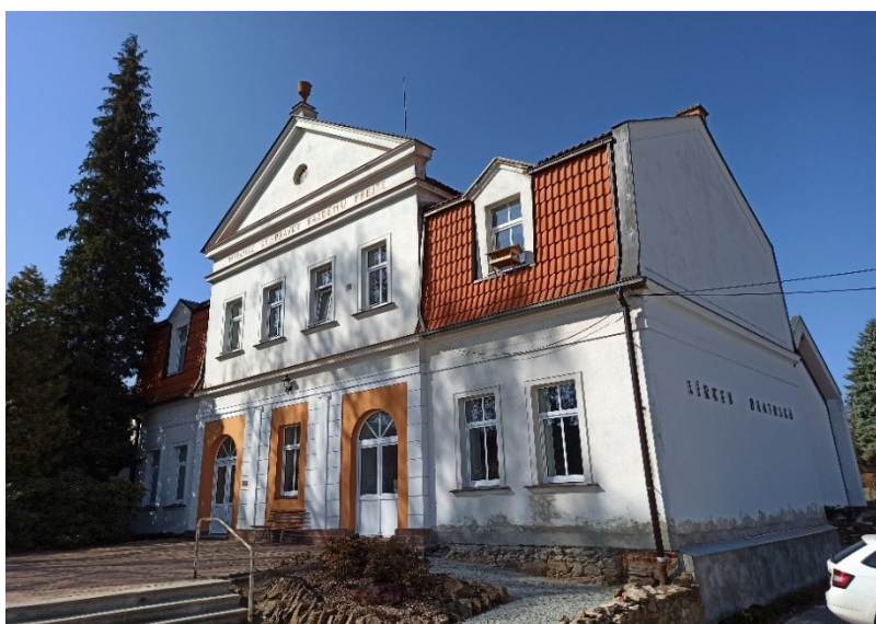
Obr. č. 3: Sbor Církve bratrské v Husinci – přední část, pohled ze severovýchodu [autor]
