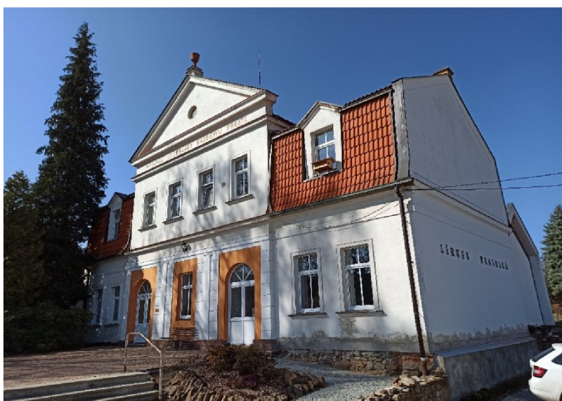
Obr. č. 3: Sbor Církve bratrské v Husinci – přední část, pohled ze severovýchodu [autor]
