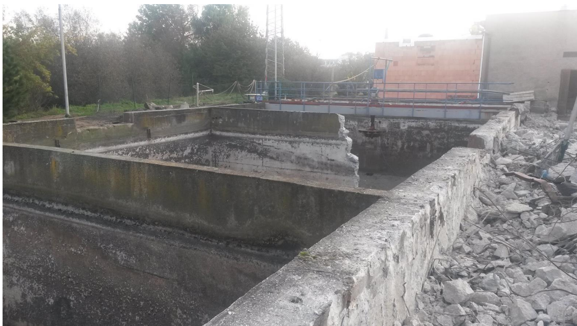
Příl. 1 – Fotografie průběhu rekonstrukce
