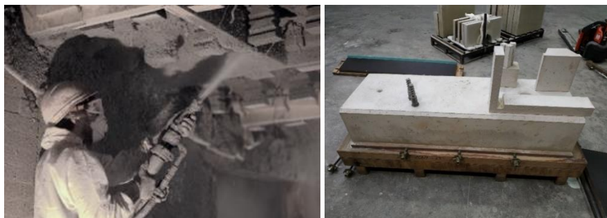
Obr. 5: Aplikace shotkretu in-situ (vlevo), odformovaný prefabrikovaný dílec (vpravo) [9]
