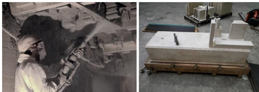
Obr. 5: Aplikace shotkretu in-situ (vlevo), odformovaný prefabrikovaný dílec (vpravo) [9]
