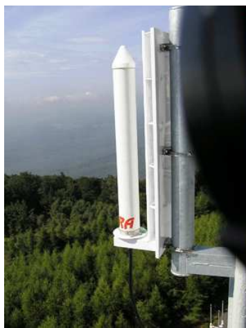
Obr.33: Anténa boční stanice P3D-WS v Jedlové Hoře [29]
