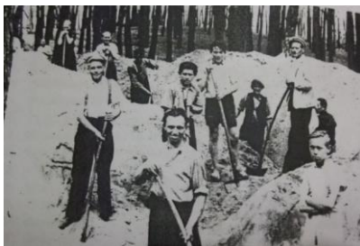
Obrázek 18 - Výstavba protiletectvého krytu 64
