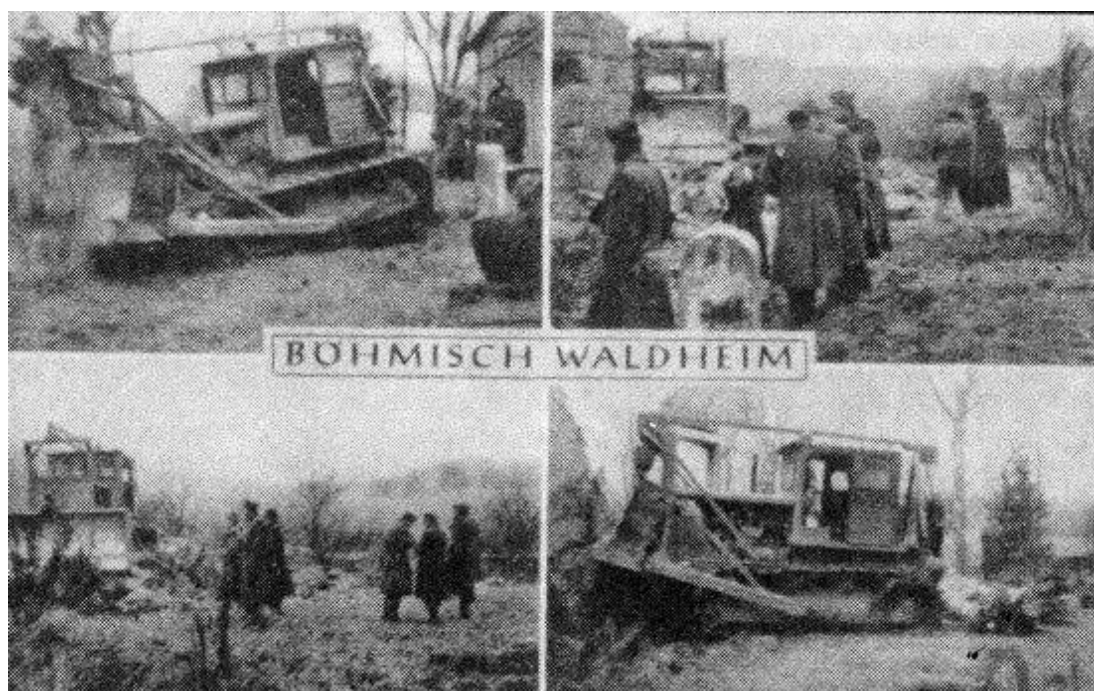
Obrázek č. 2. Demolice obce Zahájí na Tachovsku (Spurný et al., 2006).
