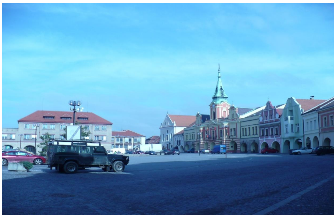
Obr. 6.3 – náměstí Míru po rekonstrukci (zdroj: Hloušová)
