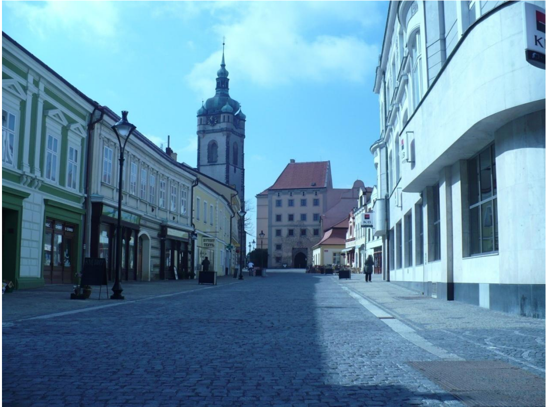
Obr. 5- ulice Svatováclavská, stoka C2 (směrem od náměstí Míru) (zdroj: Hloušová, 2011)
