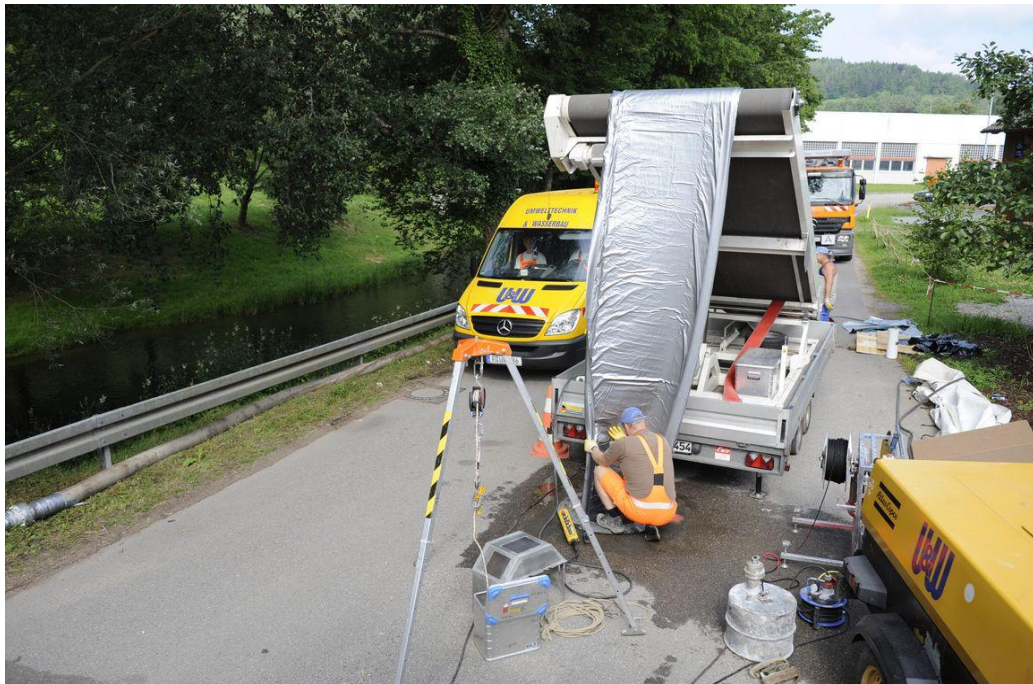
Obr. 6.4 – Instalace vložky do startovací šachty
