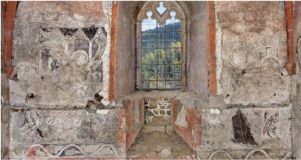
Obr. 7/ Zvěstování Panně Marii, kolem 1370, nástěnná malby, Bečov nad Teplou, kaple Navštívení Panny Marie, severní stěna presbytáře.
