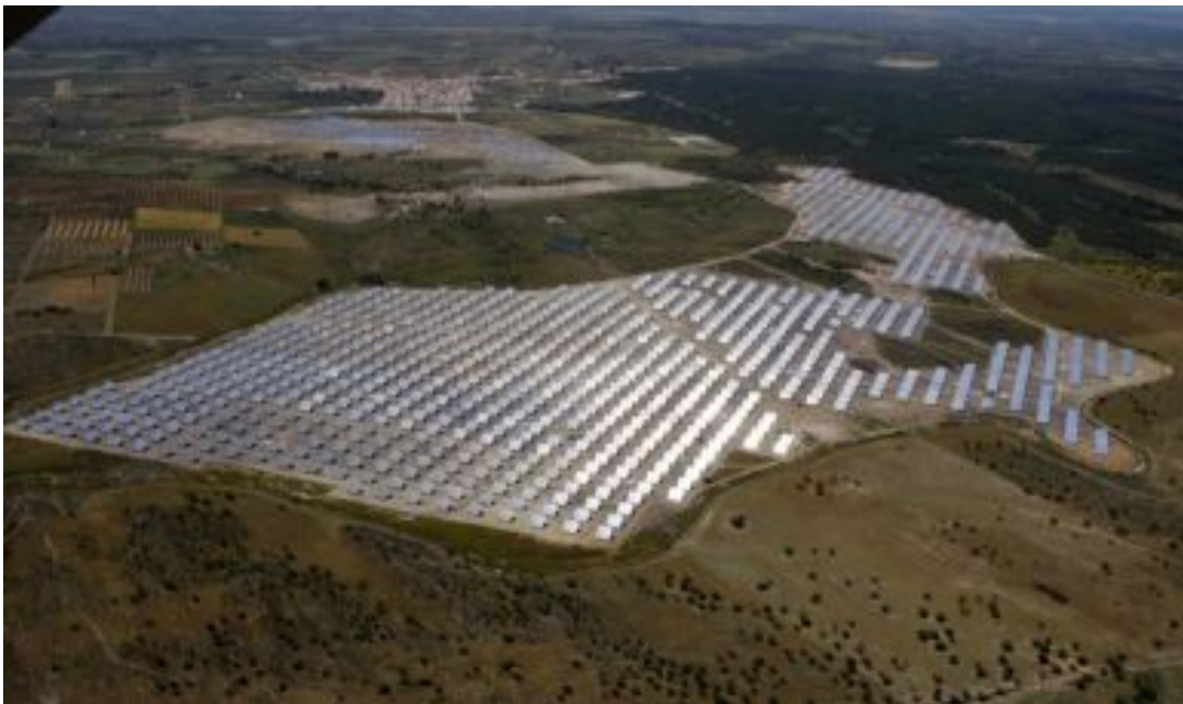
Obr. 5.4 Sluneční elektrárna v Portugalsku
