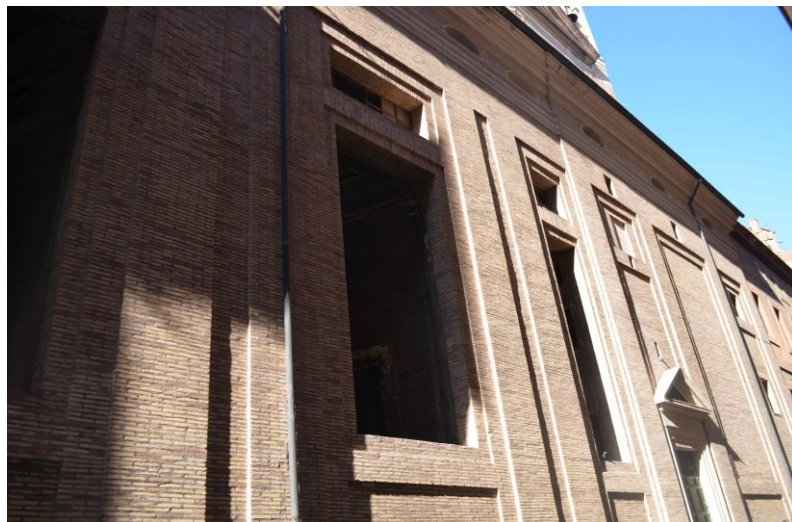
20. Boční pohled na lizény kostela Chiesa Nuova v Římě
