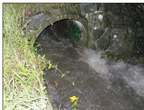
Obr. č. 72: Ústí odlehčovače při havárii 23.7.2016 (Dvořáková, 2016)
