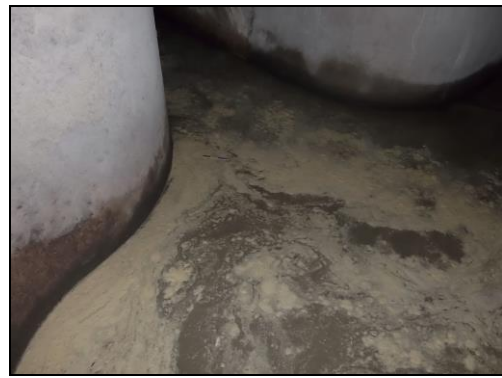
Obr. č. 65: Nefunkční odlehčovač (Pecharová, 2016) Obr. č. 66: Odlehčovač po 10 minutách (Pecharová, 2016)
