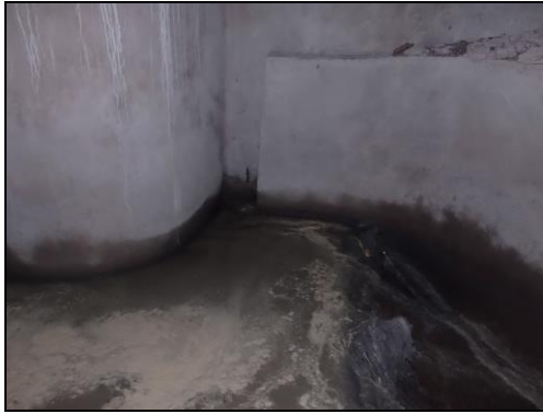
Obr. č. 65: Nefunkční odlehčovač (Pecharová, 2016) Obr. č. 66: Odlehčovač po 10 minutách (Pecharová, 2016)
