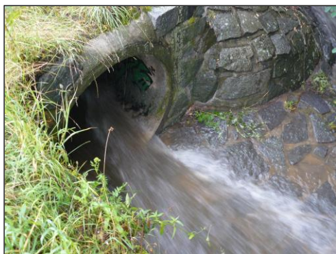
Obr. č. 73: Ústí odlehčovače, havárie (Dvořáková, 2016) Obr. č. 74: Vytékání odpadní vody (Dvořáková, 2016)
