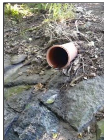
Obr. č. 45: Detail výpusťi (Dvořáková, 2015)
