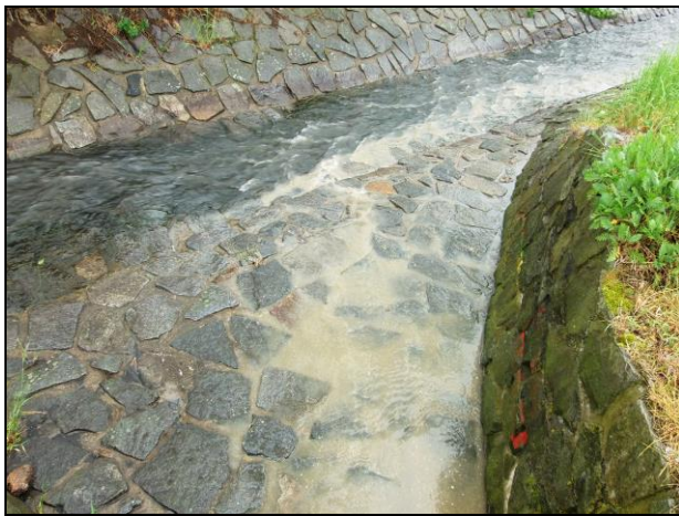
Obr. č. 67: Ústí odlehčovače (Pecharová, 2016)
