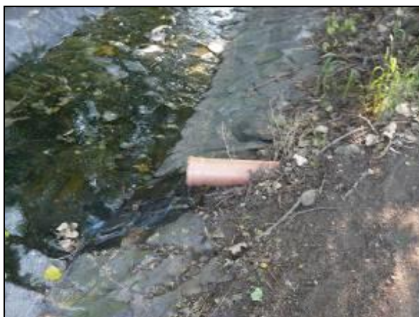
Obr. č. 44: Výpusť do vodního toku (Dvořáková, 2015)
