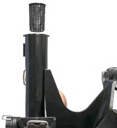
Obr. 30: Sito na vstupe do sekundárneho doskového výmenníka tepla kondenzačného kotla [33]
