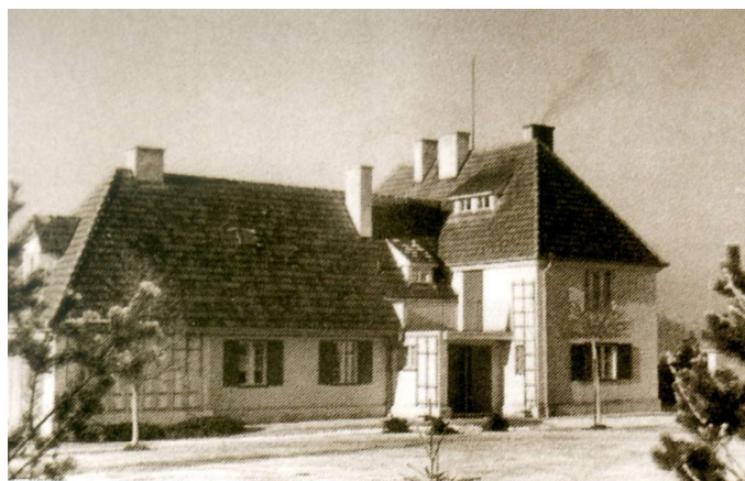
Obr.16: Východní průčelí vily Ludvíka Strimpla v r.1937 (zdroj: Zámečník, 2016)
