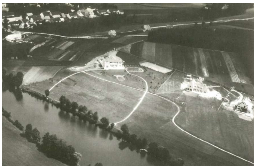
Obr.11: Letecký snímek z r. 1931 po dostavbě vil (zdroj: Kolář a Drha, 2004)
