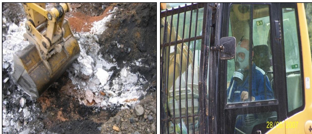
Obrázek č. 15 a 16 – Odtěžba lagun, skládek tekutého odpadu (DEKONTA, 2009)
