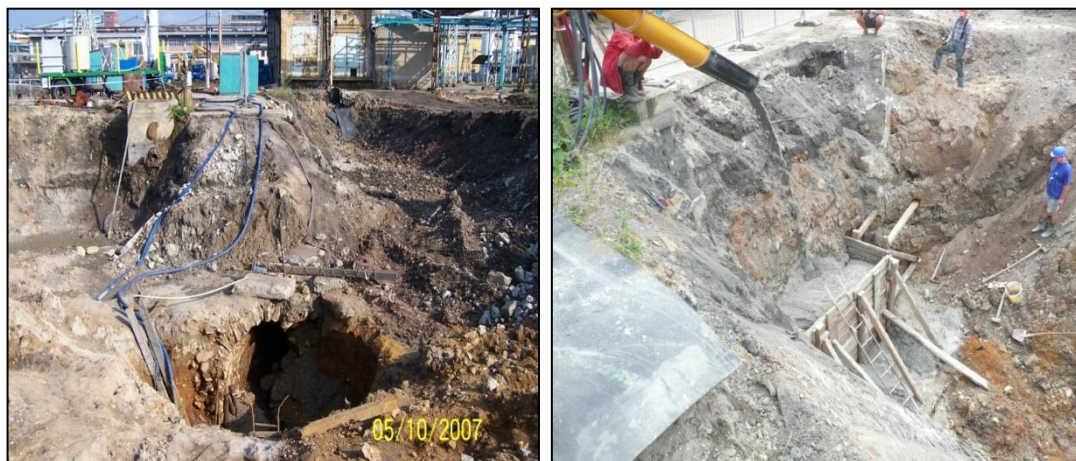
Obrázek č. 11 a 12 – Likvidace dědičné štolky Antonín (DEKONTA, 2009)
