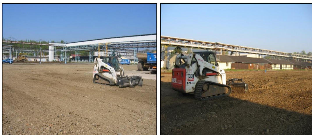
Obrázek č. 9 a 10 – Rekultivace povrchu sanačních jam (DEKONTA, 2009)
