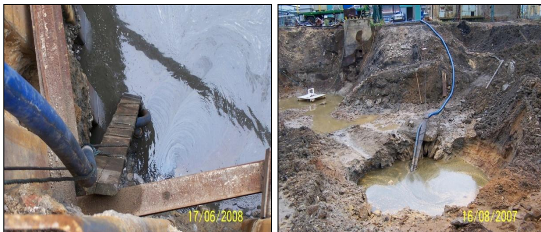
Obrázek č. 13 a 14 – Sanační čerpání podzemních vod ze sanačních jam (DEKONTA, 2009)
