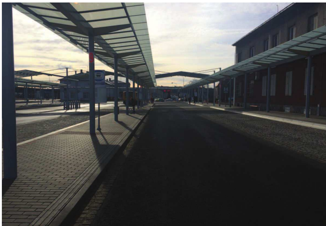
Obr. 6.4 Detail zastřešení nástupišť
