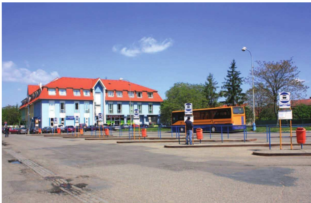
Obr. 6.1 Původní autobusové nádraží Břeclav [22]
