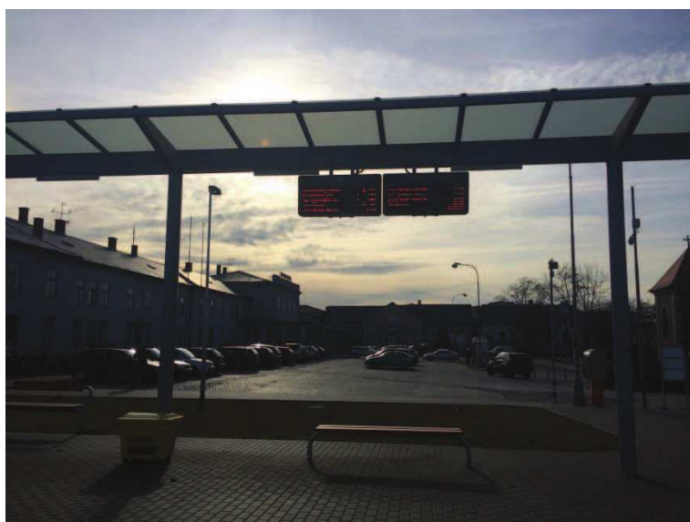
Obr. 6.7 Jediné informační tabule na celém terminálu
