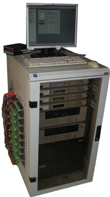
Obr. 20: Skříň a uspořádání přístrojů automatizovaného měřicího pracoviště
