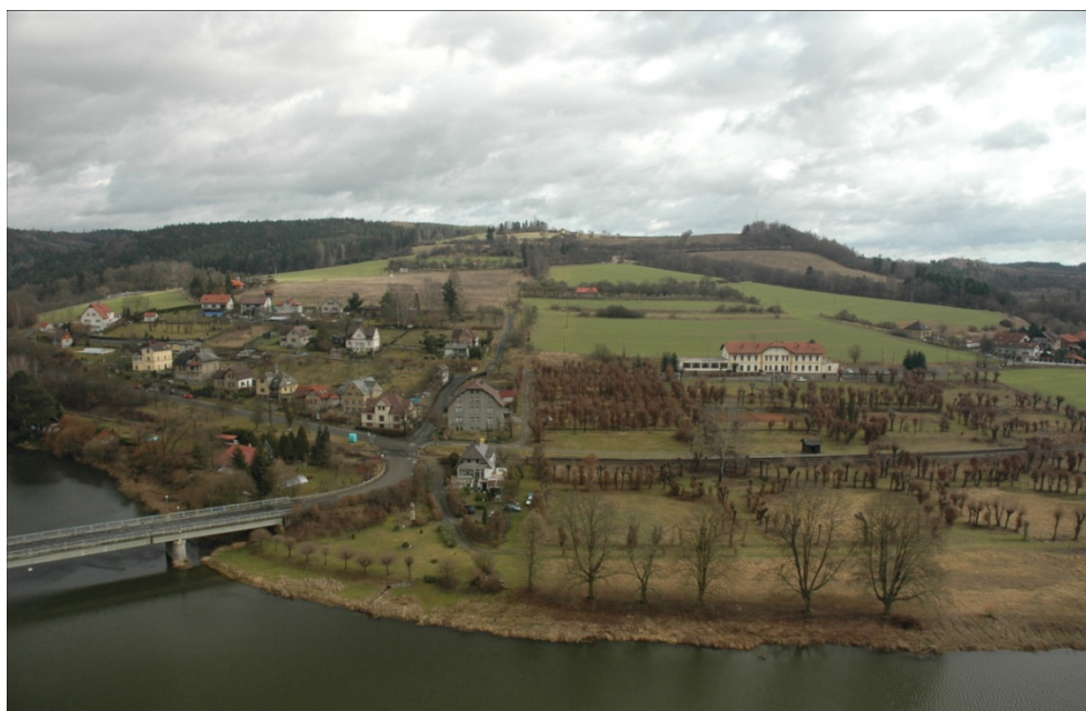
Pohled na Parkhotel a zbytky původního francouzského parku v Českém Šternberku. Foto Mgr. H. Hořejší.
