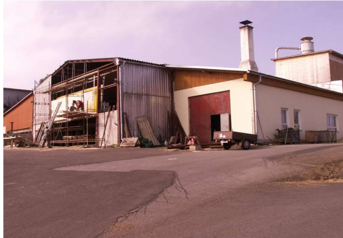
Obrázek 2: Pila Černá při rekonstrukci (Novotný 2009)
