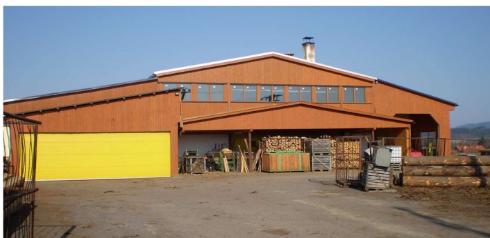
Obrázek 4: Pila Černá po rekonstrukci (Novotný 2009)
