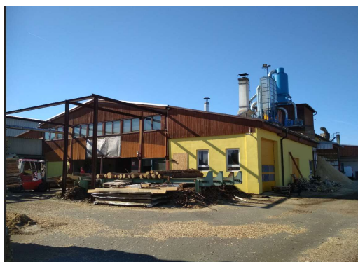
Obrázek 7: Hlavní budova Pila Černá
