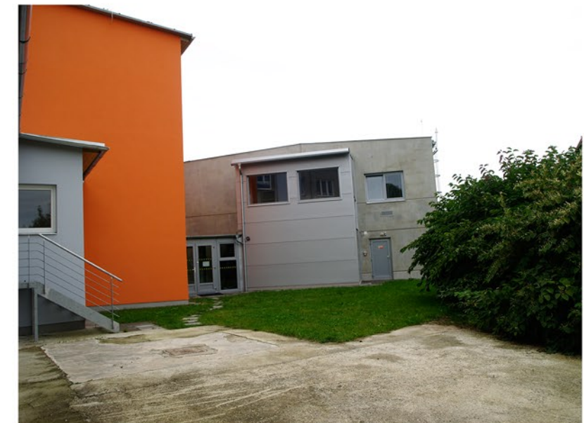
přístavba tělocvičny z pohledu vjezdu k jímkám
