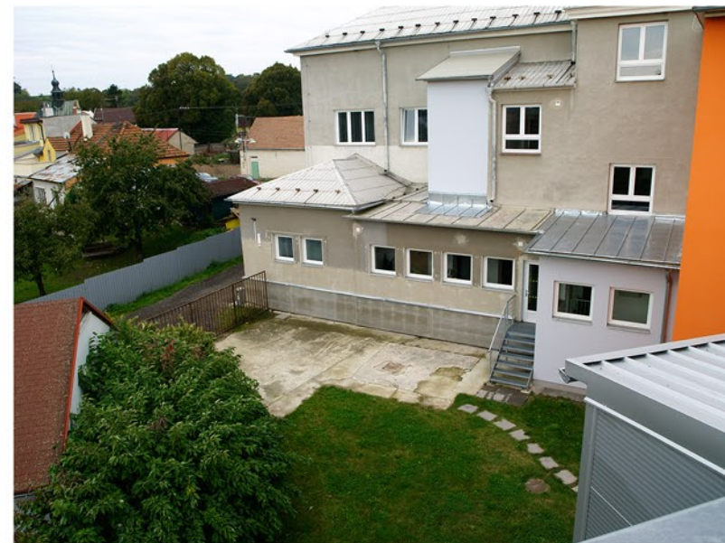
budova radnice zezadu z technického dvora
