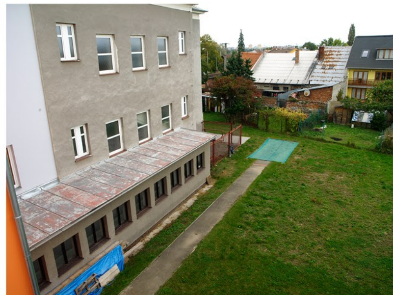
pohled na spojovací chodbu, hlavní budovu a doskočiště
