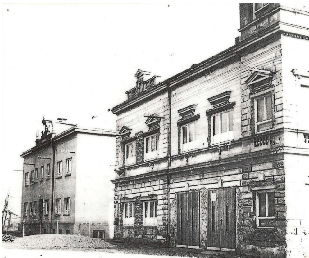
Obr. č. 40 Podoba místa z poválečného období, kdy byla v přízemí budovy bývalé radnice zřízena mateřská škola
