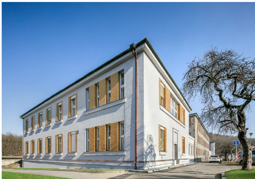
Obrázek 3 Rekonstrukce Thomayerovy nemocnice
