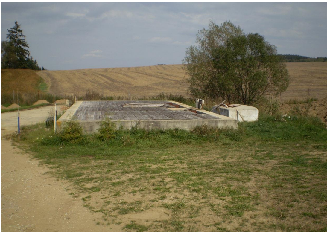
Foto: Petr Adamec, pracovník skládky Jímka průsakových vod
