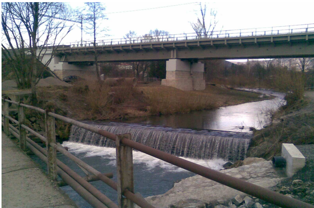
Obr. č. 12: Vyhovující, nově zrekonstruovaný železniční most č. 6, jez č. 7 a silniční most č. 8 na řece Hlučové (Lucie Čmielová).
