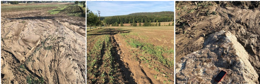
Obr. č. 13 - Dokumentace vodní eroze Kublov
