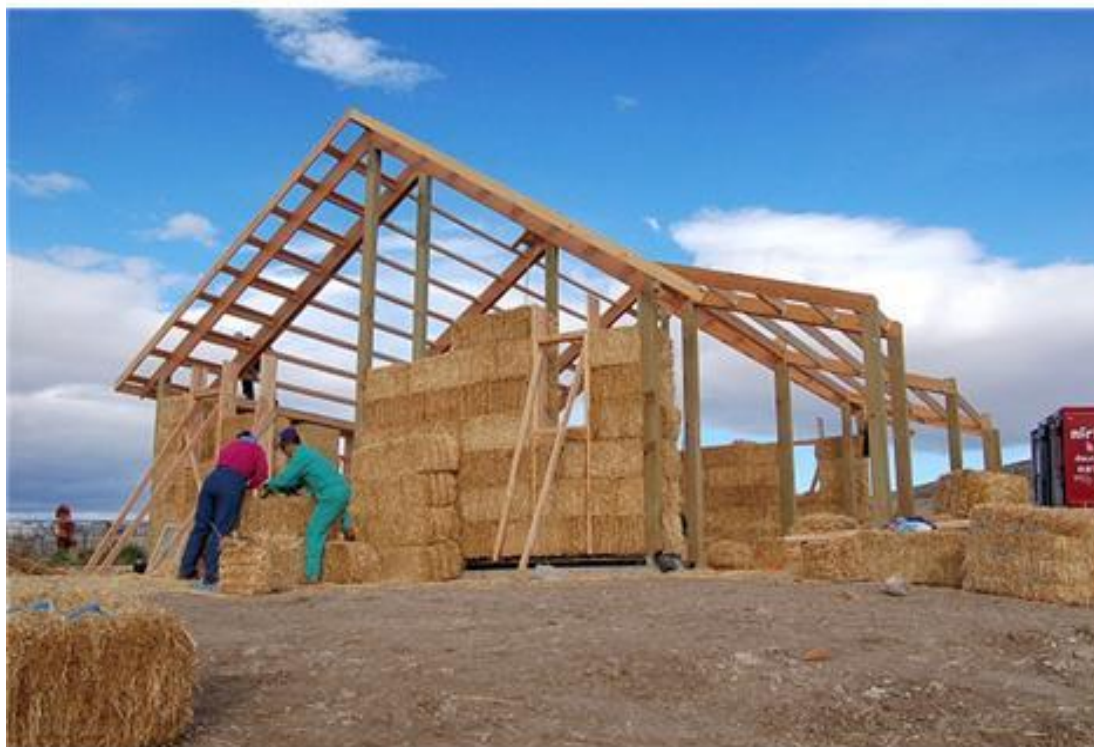
Obr. č. 4: Stavba domu ze slámy
