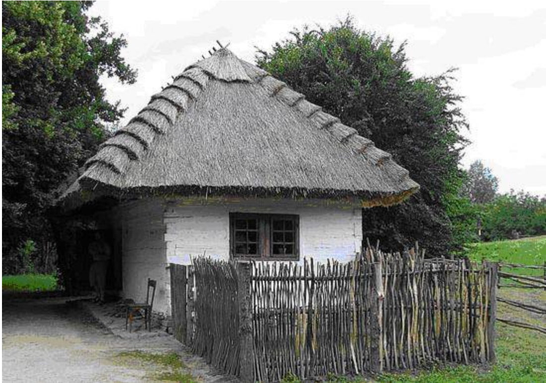
Obr. č. 9: Došková střecha
