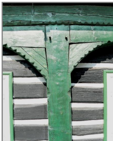
Obrázek 15 sloupek, rozpěra, ližina i pásy zdobeny zoubkovaním; Jetřichovice, foto Václav Sojka, zdroj: www.drevoastavby.cz
