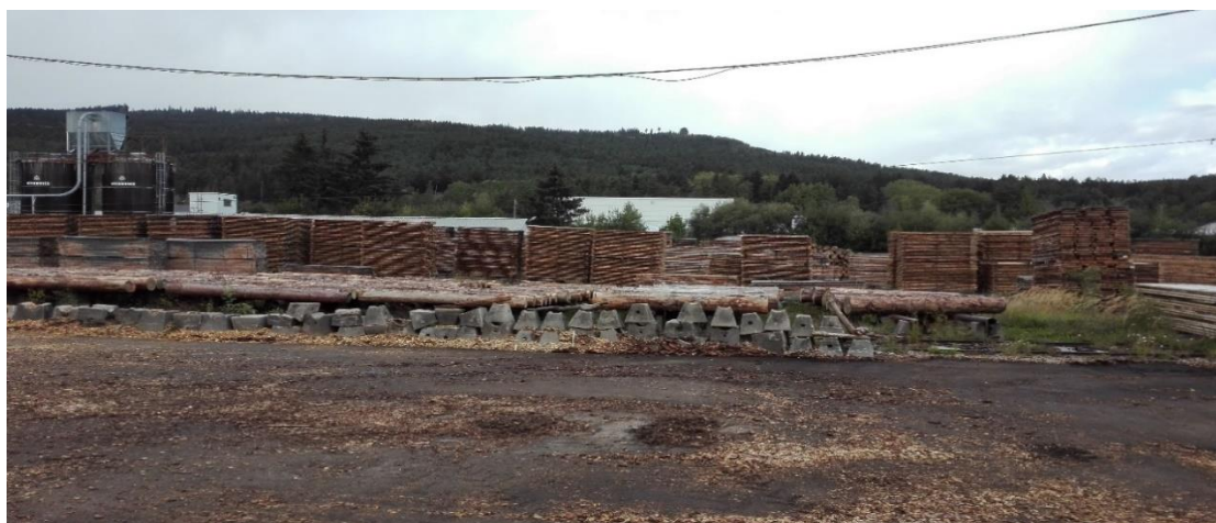
Obrázek č. 6: Část dřevoskladu podniku Lira v Českém Krumlově, na kterém je patrné uskladnění kulatiny i vyrobeného řeziva
