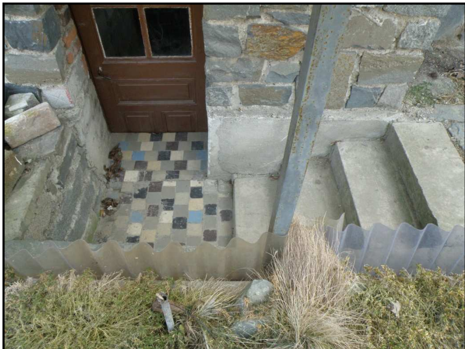
Obrázek 20 – Schodiště (vstup sklep RD nový) (2)
