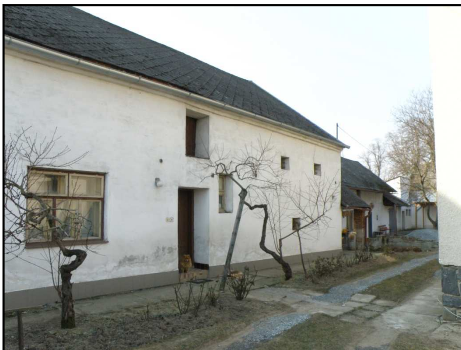
Obrázek 3 – RD starý (B) a příjezdová komunikace
