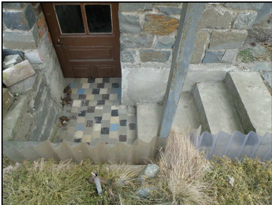
Obrázek 20 – Schodiště (vstup sklep RD nový) (2)
