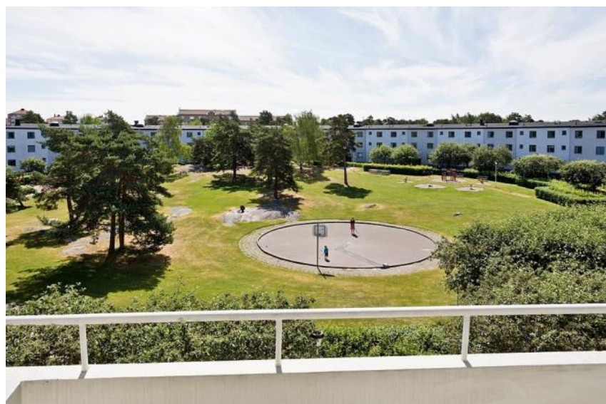
Obrázek č.11 – Pohled do vnitřního prostoru bloku
