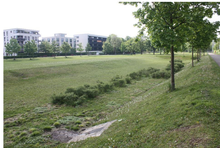
Obrázek č.7 – Vsakovací nádrž na dešťovou vodu
