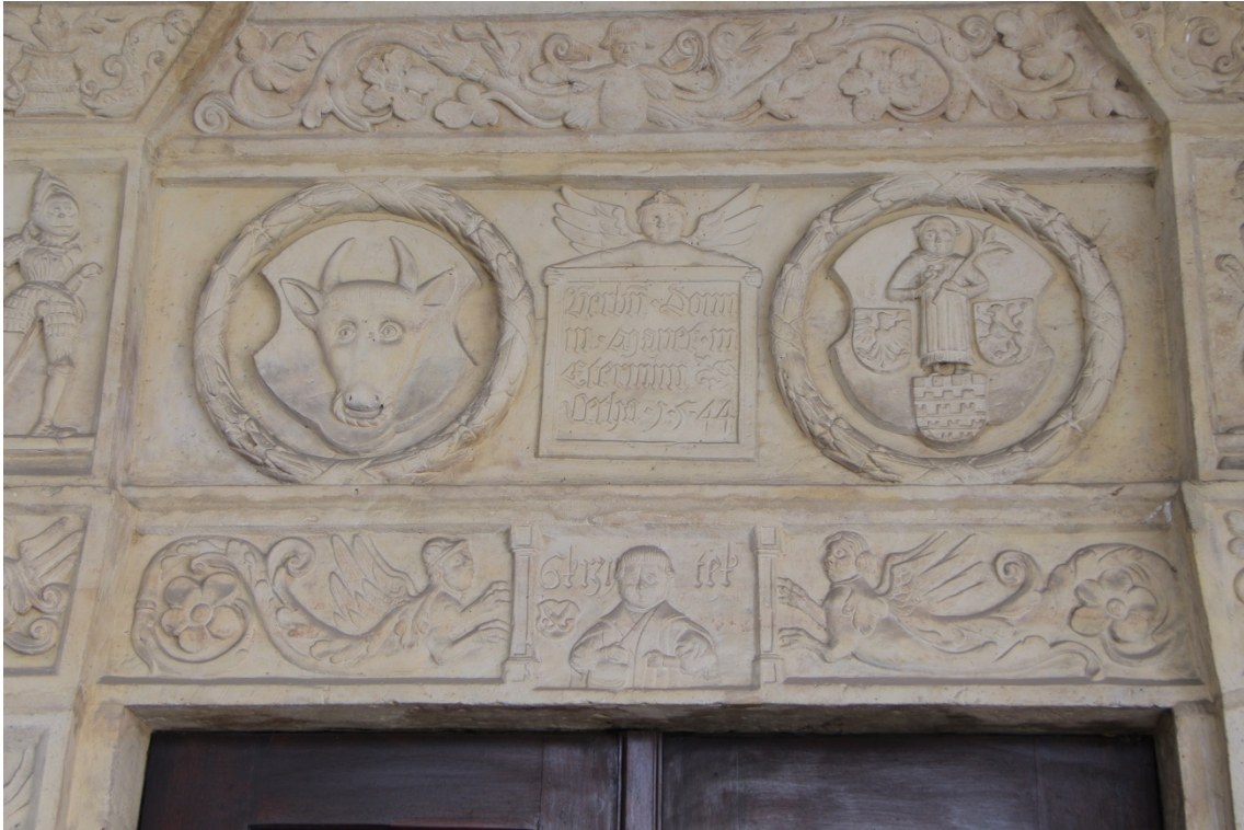
67. Hranice, radnice, portál, detail nadpraží s nápisovou deskou, 1544
