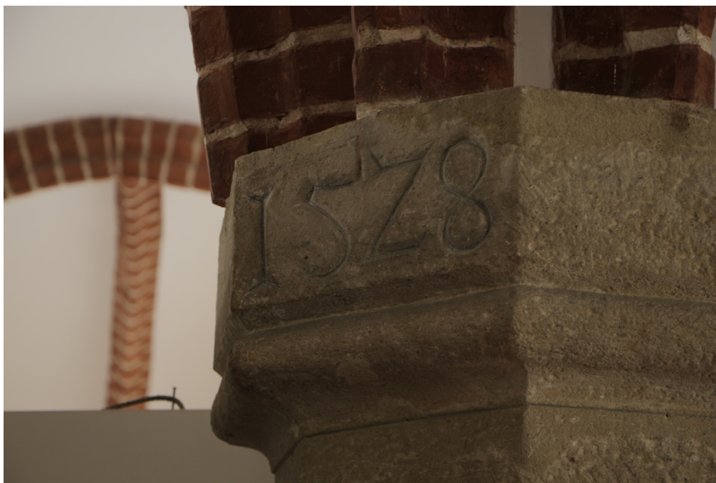
65. Hranice, radnice, gotický sál, detail pilíře s letopočtem, 1528
