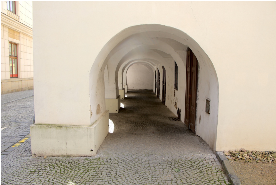
23. Hranice Janáčkova ulice, loubí domu č. p. 728
