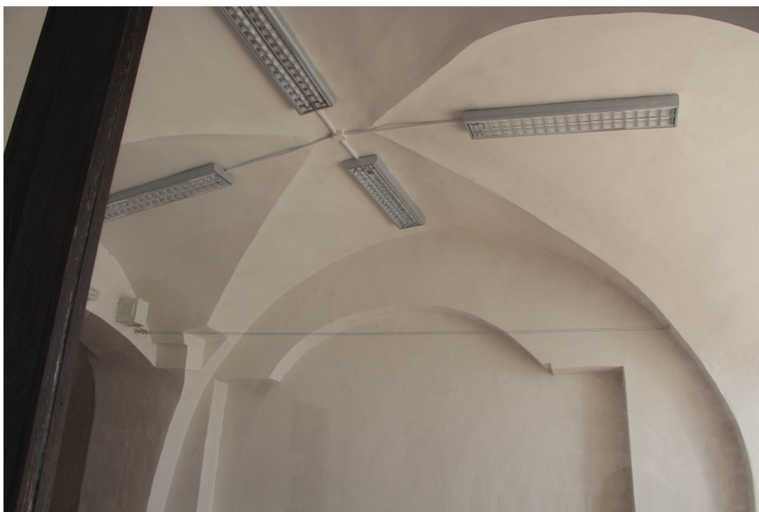
82. Hranice, měšťanský dům, Masarykovo náměstí č. p. 20, pravá část domu, zaklenutí prodejny, 80. léta 16. století
