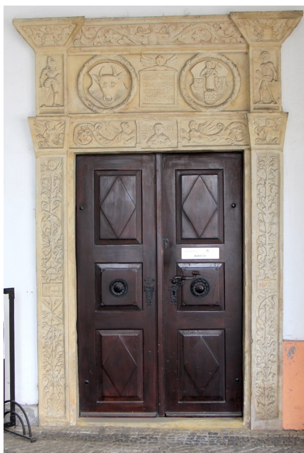
66. Hranice, radnice, portál, 1544
