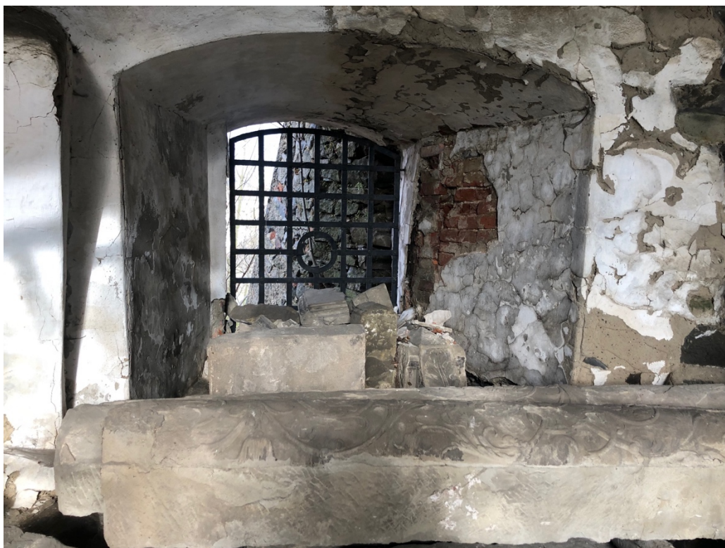
49. Hranice, zámek, fragmenty původního renesančního portálu v současném umístění
