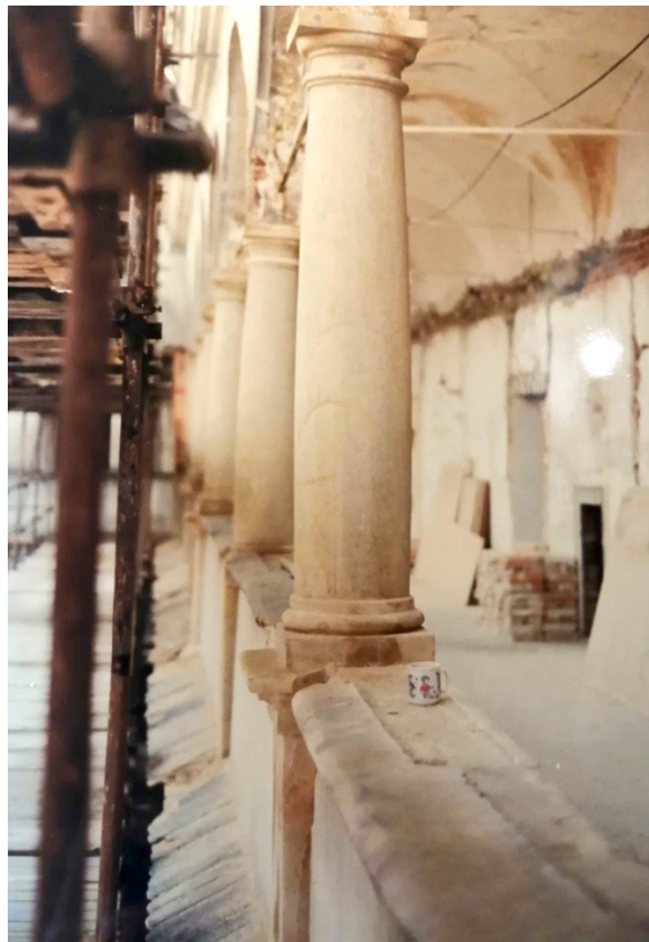
42. Hranice, zámek, foto z rekonstrukce arkád, 1997
