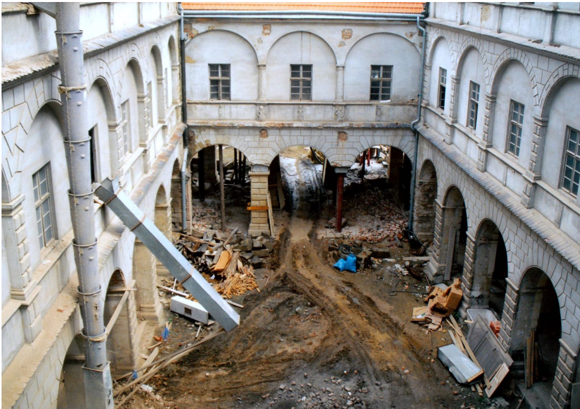
45. Hranice, zámek, nádvoří, pohled na severní křídlo při rekonstrukci 1996–1998
