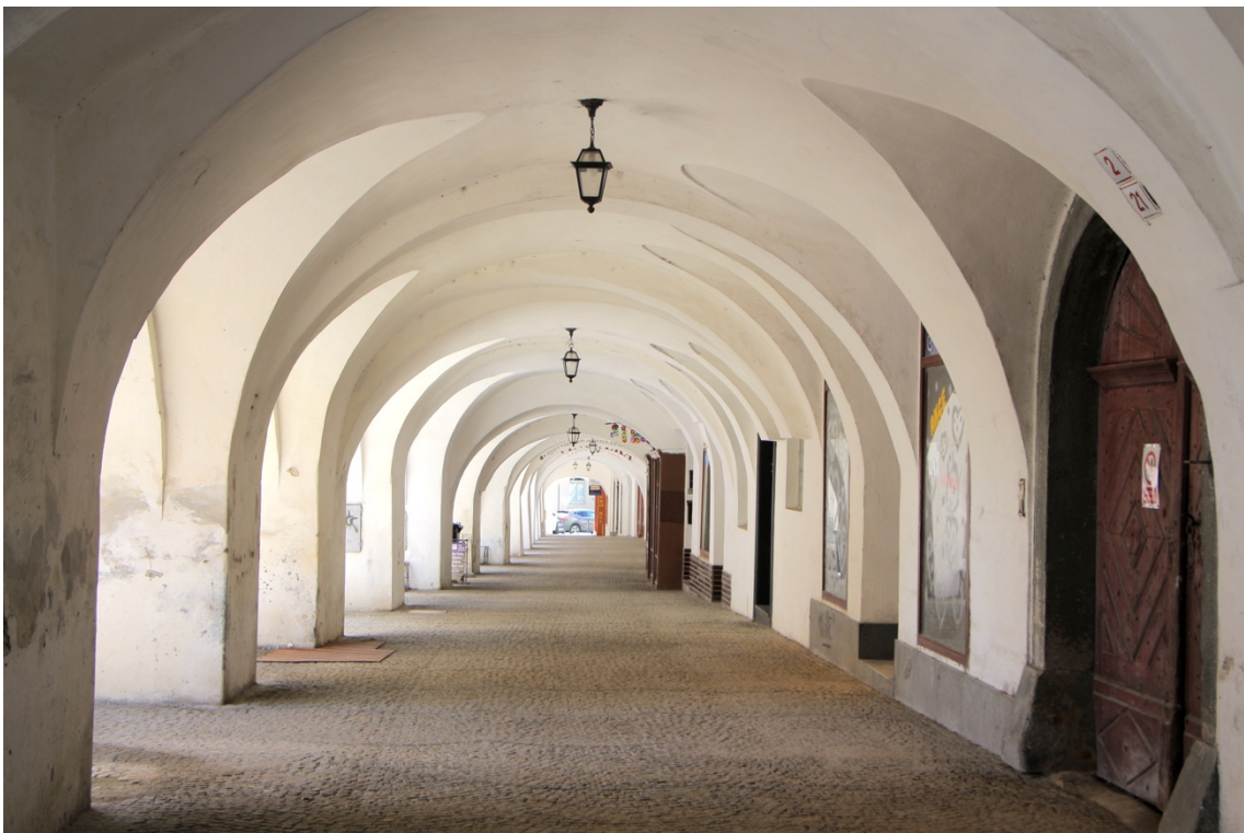
18. Hranice, Radniční ulice, loubí
