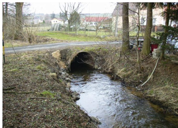
Cestní propustek v ř. km 3,800 [2] Road culvert at the 3,800 river km
