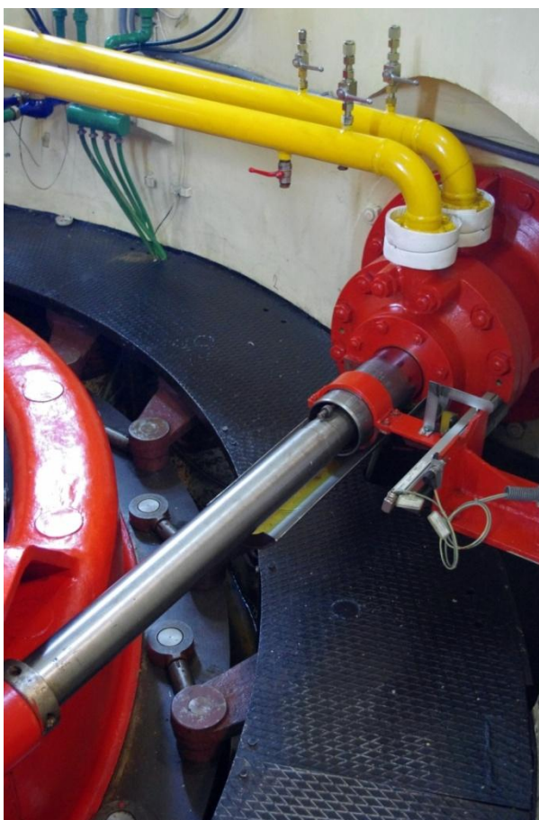
Příloha č. 16 - Rozváděcí kruh s ovládacím mechanismem na středotlaké Kaplanově turbíně.
