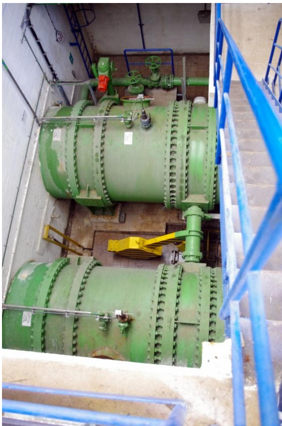
Příloha č. 14 - Vyrovnávací komora na přivadčích v pohledu od horní nádrže.
