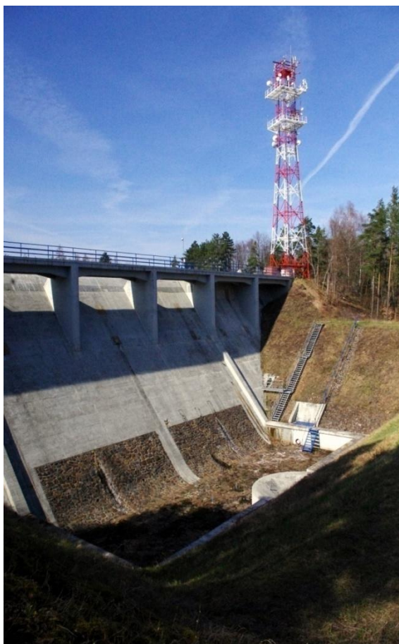
Příloha č. 6 - Horní akumulční nádrž v pohledu na stěny s vtokovým a přelivným objektem.
