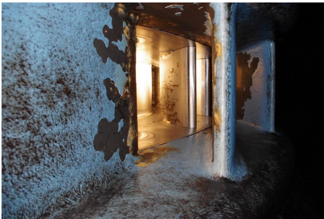
Příloha č. 16 - Rozváděcí kruh s ovládacím mechanismem na středotlaké Kaplanově turbíně.
