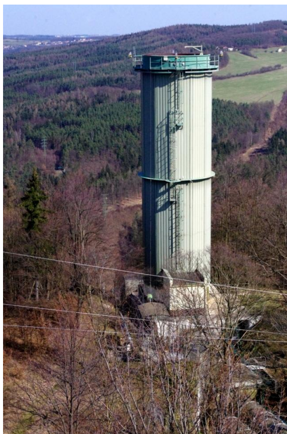
Příloha č. 14 - Vyrovnávací komora na přivadčích v pohledu od horní nádrže.
