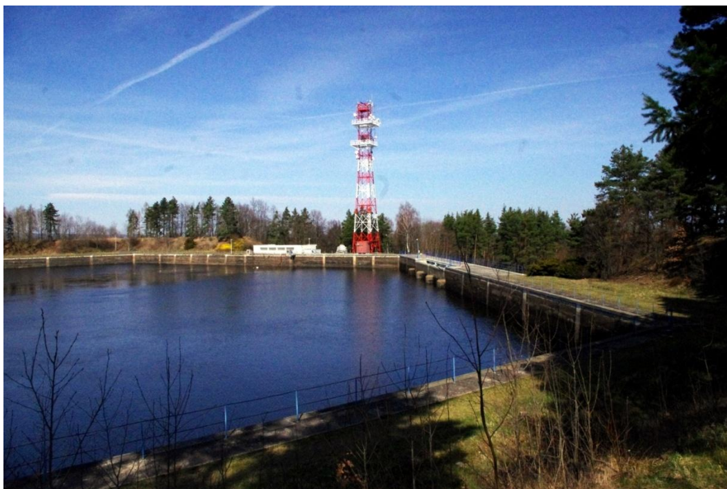
Příloha č. 6 - Horní akumulční nádrž v pohledu na stěny s vtokovým a přelivným objektem.
