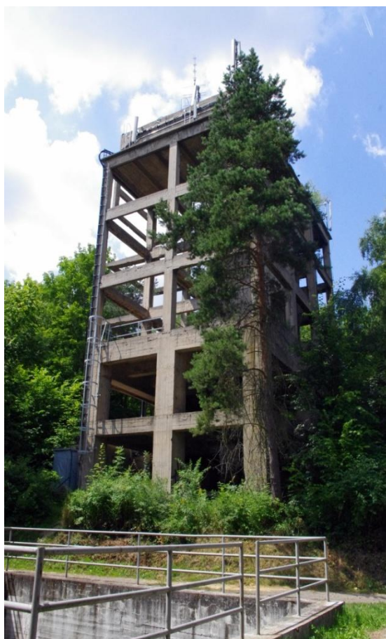
Příloha č. 4 - Budova betonárky používaná při stavbě horní akumulční nádrže.
