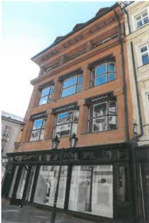
Obr. č. 15 – Severní fasáda domu, pohled z Celetné ulice.
