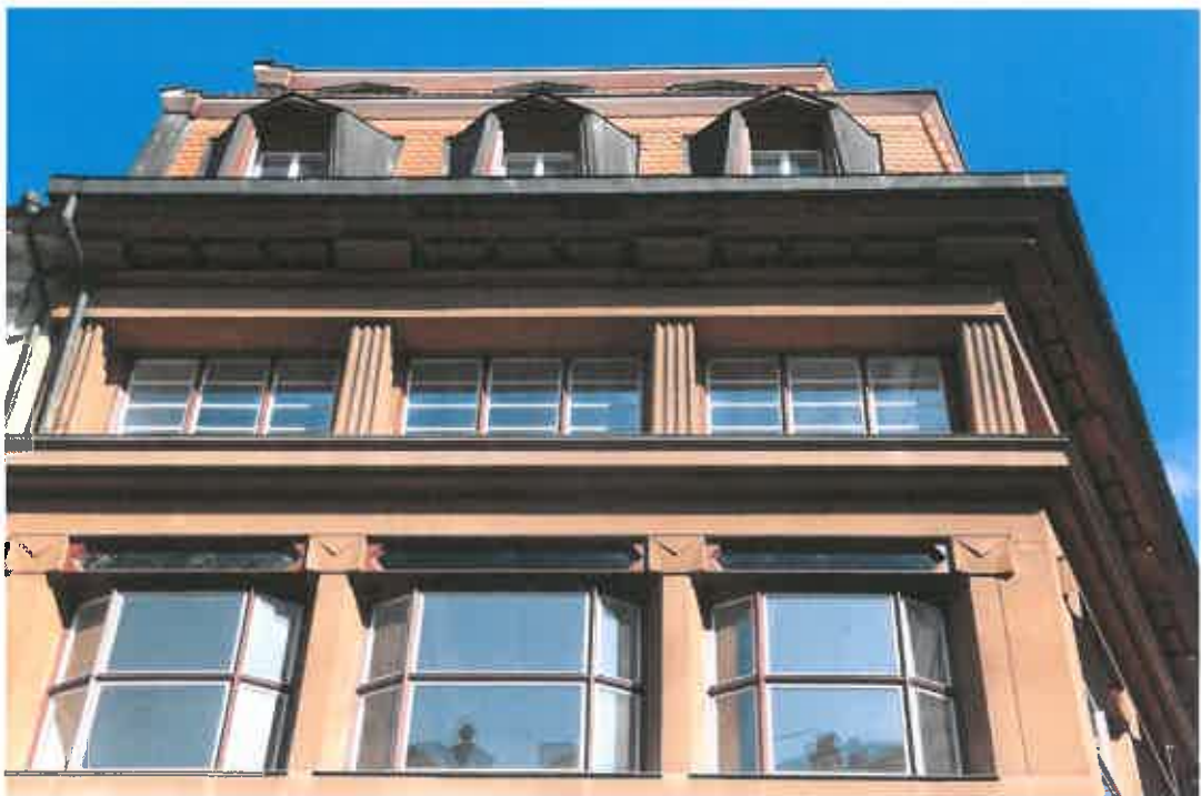
Obr. č. 17 – Jižní fasáda domu, detail, pohled z ulice Ovocného trhu.
