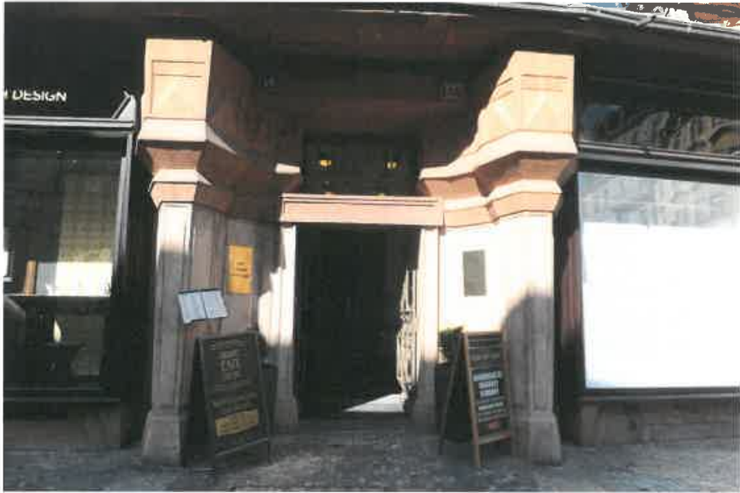
Obr. č. 10 – Portál hlavního vchodu domu (otevřený).
