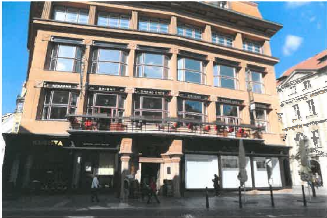
Obr. č. 8 – Průčelí domu, pohled od východu.
