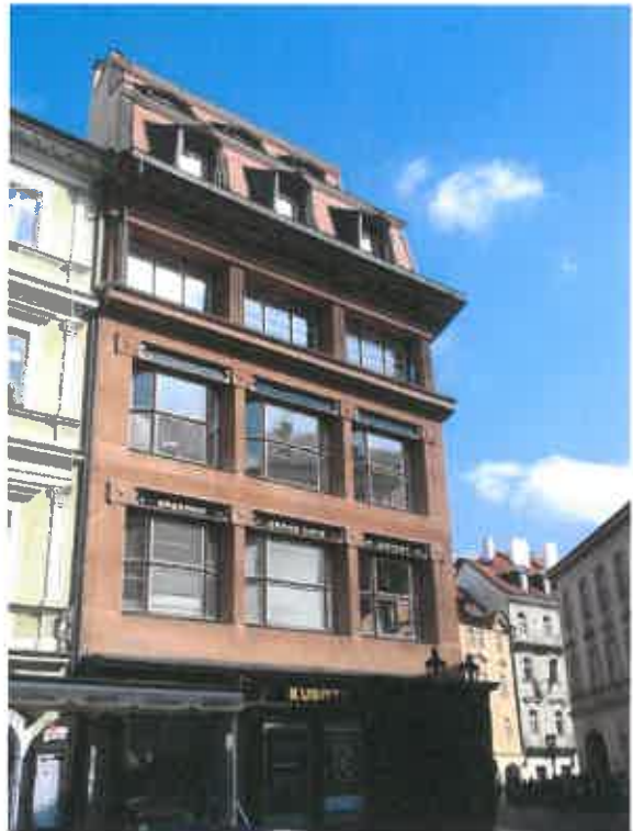
Obr. č. 16 – Jižní fasáda domu, pohled z ulice Ovocného trhu.
