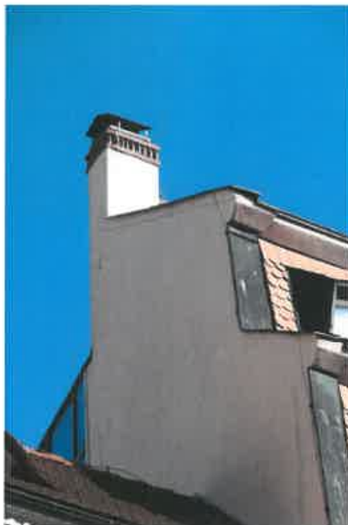
Obr. č. 19 – Detail západní části domu, prosklená střecha.
