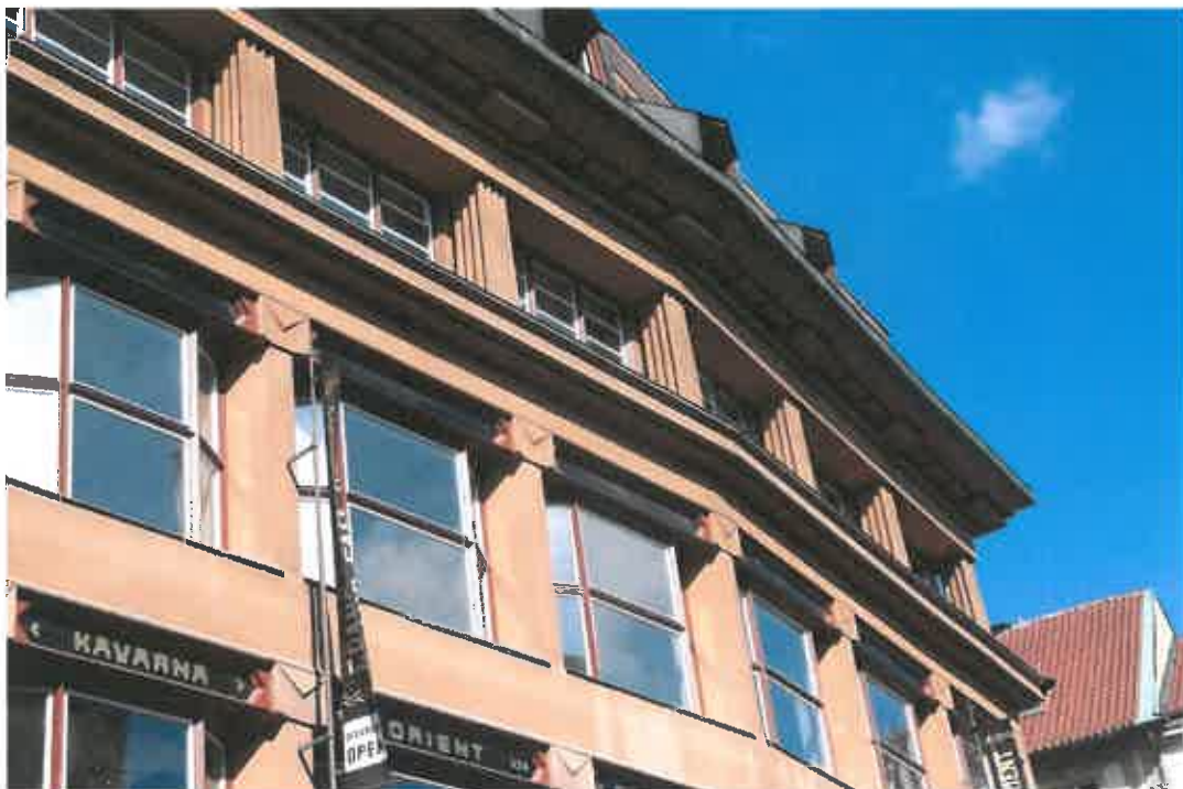
Obr. č. 9 – Lomená hrana průčelí domu.
