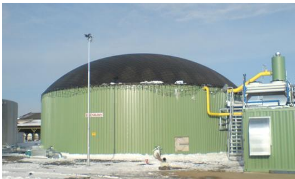
Obrázek 16. – Dodatečný fermentor s integrovaným zásobníkem plynu
