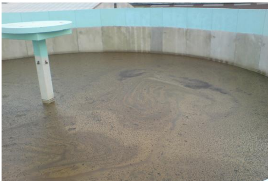
Obrázek 17. – Koncový sklad se zabudovanou středovou podporou
