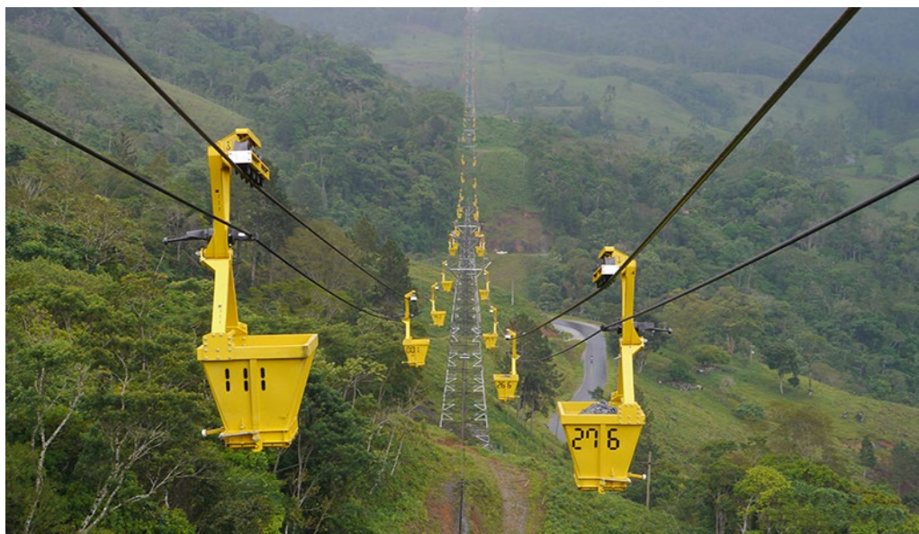
Obr.4: Moderní visutá nákladní lanová dráha (Kallista, Pašek 2016)
